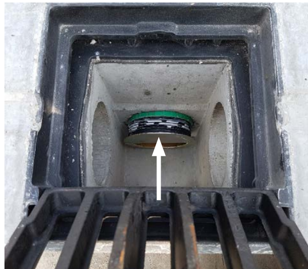
Einbau Geruchsverschluss
